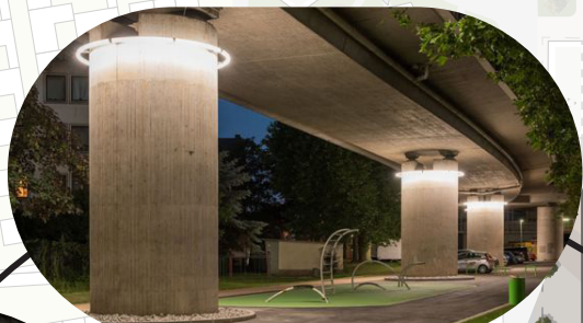
Beleuchtung der U-Bahn-Unterführung
